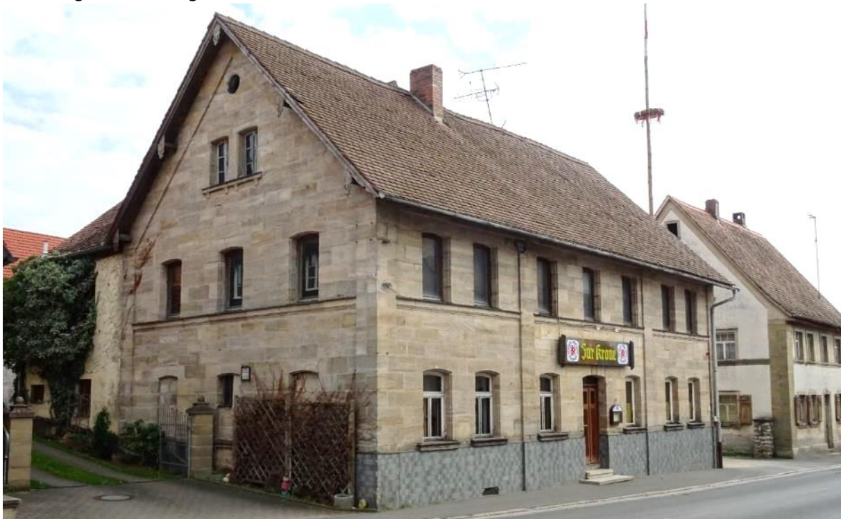
Ehemaliges Gasthaus „KRONE“ , Quelle: RSP
